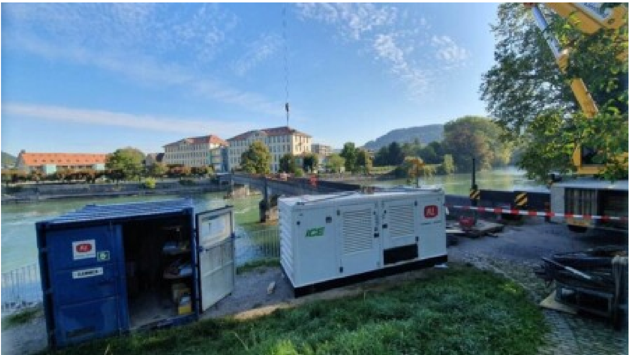
Sofortmassnahme, Einvibrieren der Stahlträger
