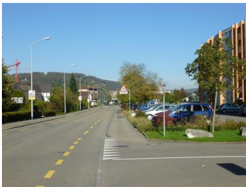
Abbildung 58: Hauptsammelstrasse: Badstrasse Brugg
