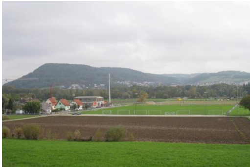
Abbildung 42: Sportplätze Aegerte und Siedlung Hüslimattstrasse
