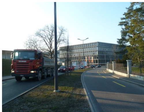
Abbildung 37: Zürcherstrasse mit Campus
