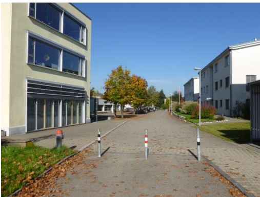
Abbildung 69: Fahrverbot resp. Aufhebung der Verbindung für den MIV beim Schulhaus Chapf in Windisch
