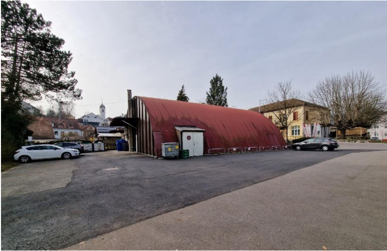
Neuer Belag Parkplatz Dorfladen «Treffpunkt Unterdorf»
