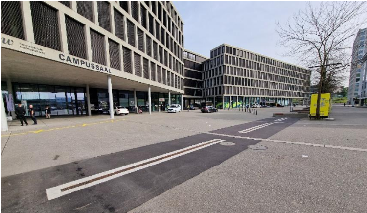
Neue Schwerlastrinne beim Campus
