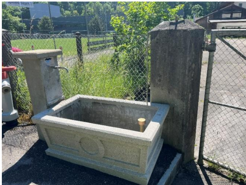
Sanierter Brunnen Sportplatz Dägerli
