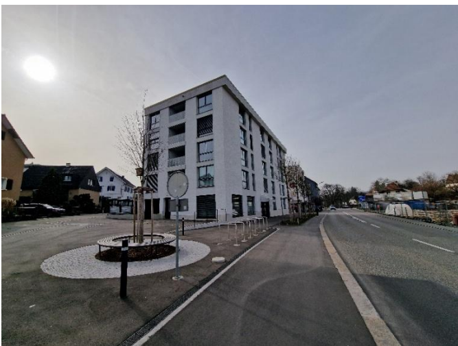
Anschluss Zürcherstrasse mit Baumgruben
