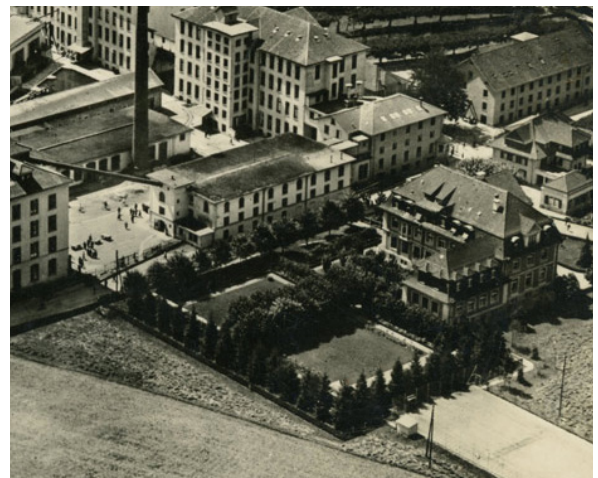
Foto um 1930: Aussenraum mit streng gestaltetem Baumraster. Bereits sind erste Veränderungen am Dach sichtbar.
