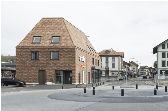
Dachhaut wird zur Fassade (Allover), in der Umsetzung werden die Schwierigkeiten der Idee sichtbar
