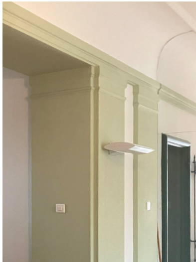
Wandverkleidung mit Fries, Hohlkehle und aufgesetzten Säulen in Korridor und Erschliessung
