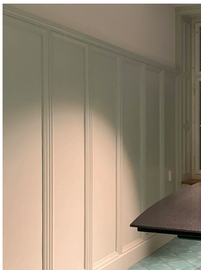
Wandverkleidung im 2. OG
