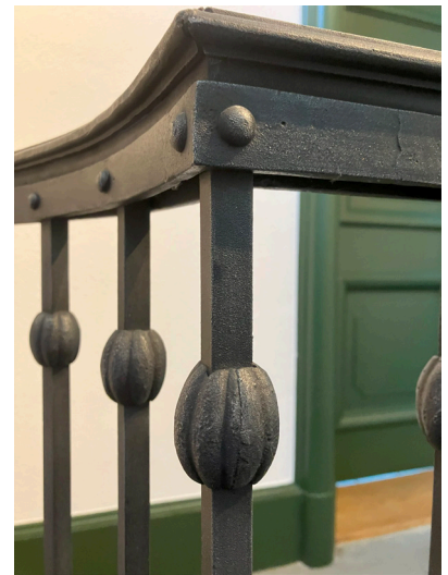
Treppengeländer Seiteneingang Süd
