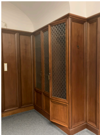
Büro im EG. Originale Wandverkleidung mit Einbauschränken.
