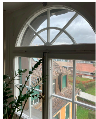
Bogenfenster im Treppenhaus
