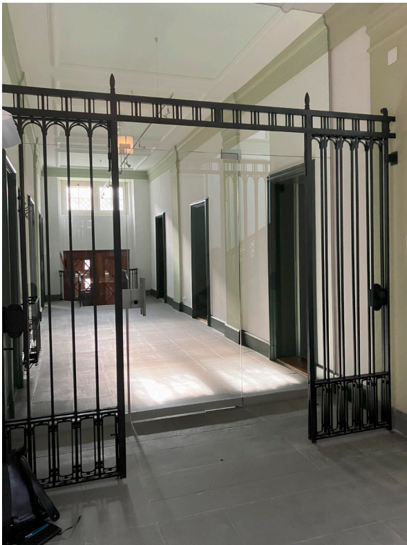
Korridor im EG mit Trennungsgitter aus Gusseisen
