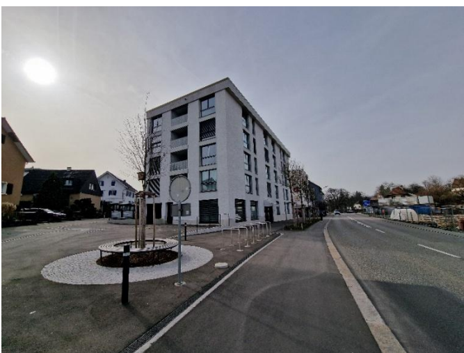
Anschluss Zürcherstrasse mit Baumgruben
