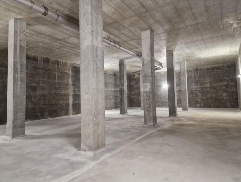
Innenraum des Reservoirs
