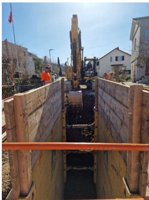
Kanalisationsarbeiten Lettenstrasse
