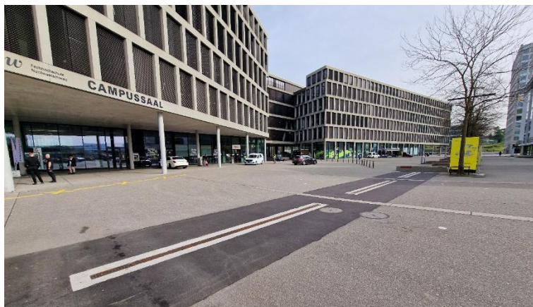
Neue Schwerlastrinne beim Campus
