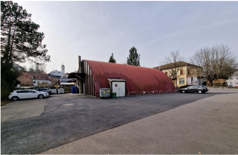
Neuer Belag Parkplatz Dorfladen «Treffpunkt Unterdorf»
