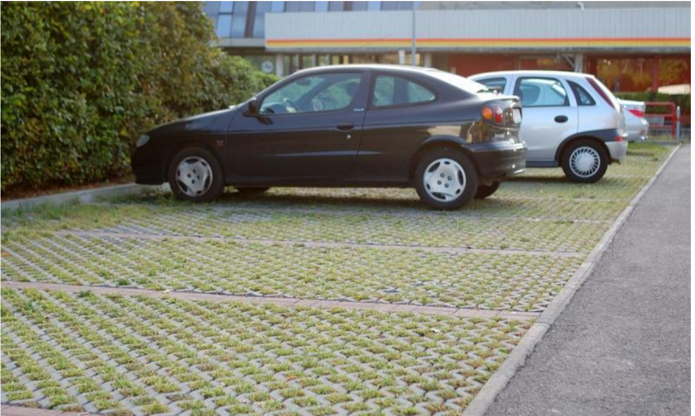
Abbildung 7: Entsiegelung mit Rasengittersteinen
