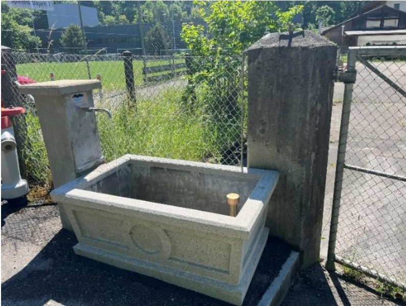
Sanierter Brunnen Sportplatz Dägerli
