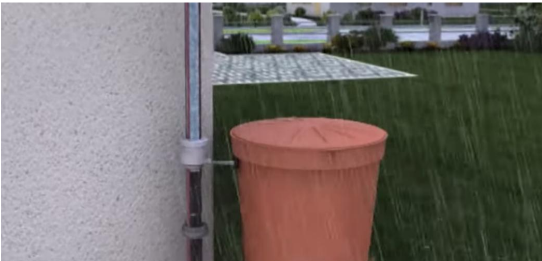
Abbildung 1: Beispielbild Regentonnen gespeist vom Regenwasser des Daches
