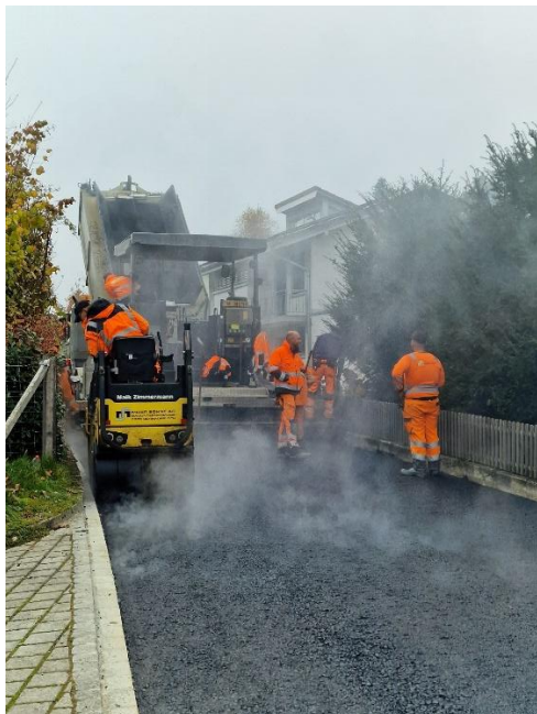
Belagseinbau im Moos
