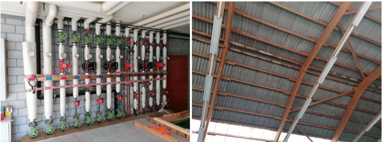
Abbildungen 1 und 2: Ansicht der Heizverteilung, Innenansicht des Daches
