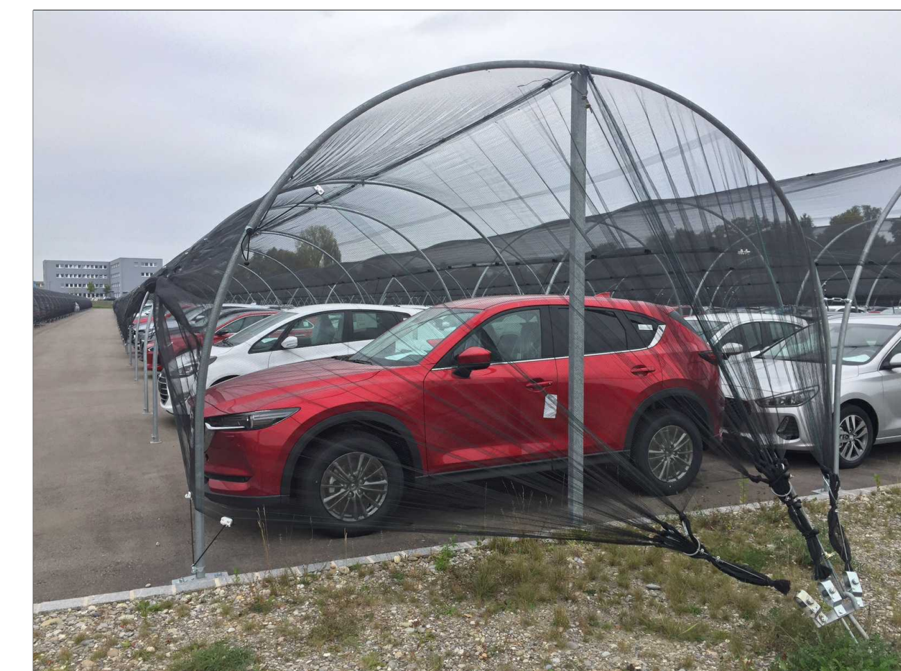
Foto: baugleiche Anlage in Möhlin (AG)
