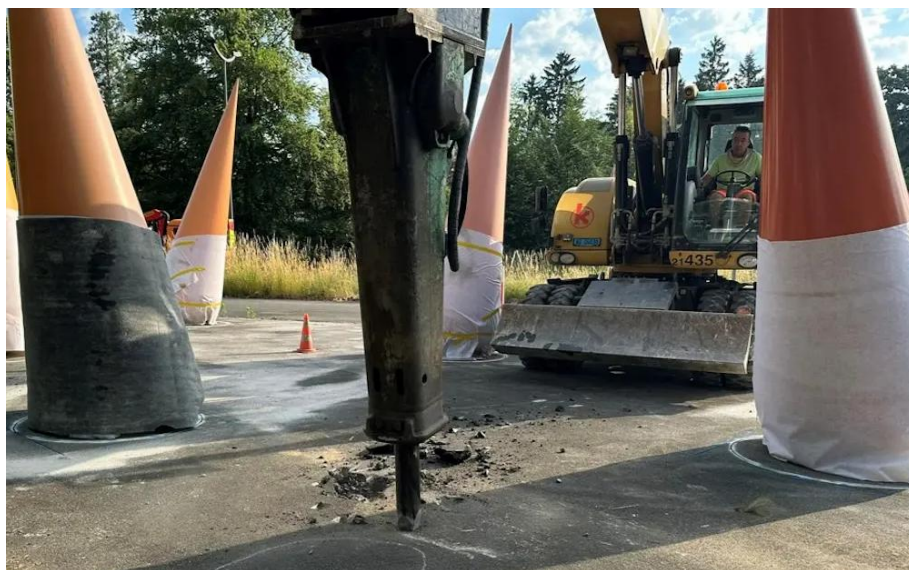
Abb. 2: Entsiegelung im Rahmen des Projekts «Asphaltknacker» bei der FHNW
