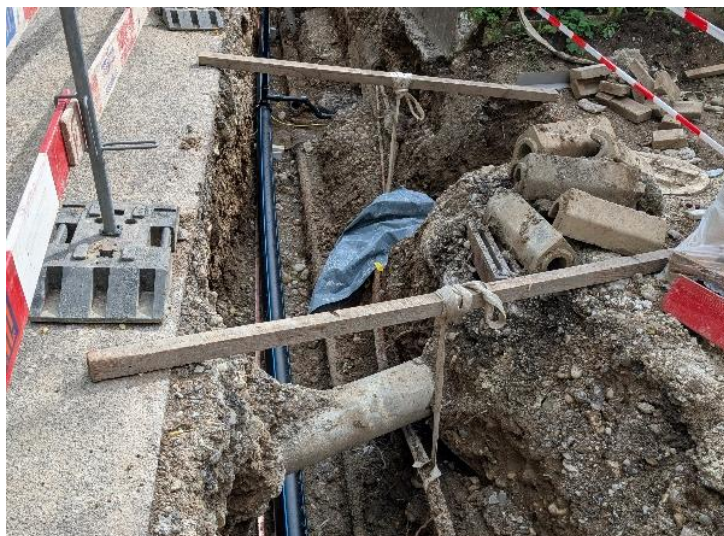
Abbildung: offener Wasserleitungsgraben in der Ringstrasse
