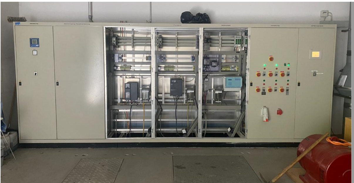
Abbildung: erneuerte Schaltschränke PW Schachen
