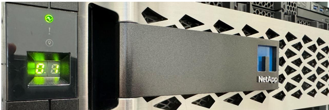
neues Datenbackup an einem externen Standort ausserhalb des Gemeindehauses
