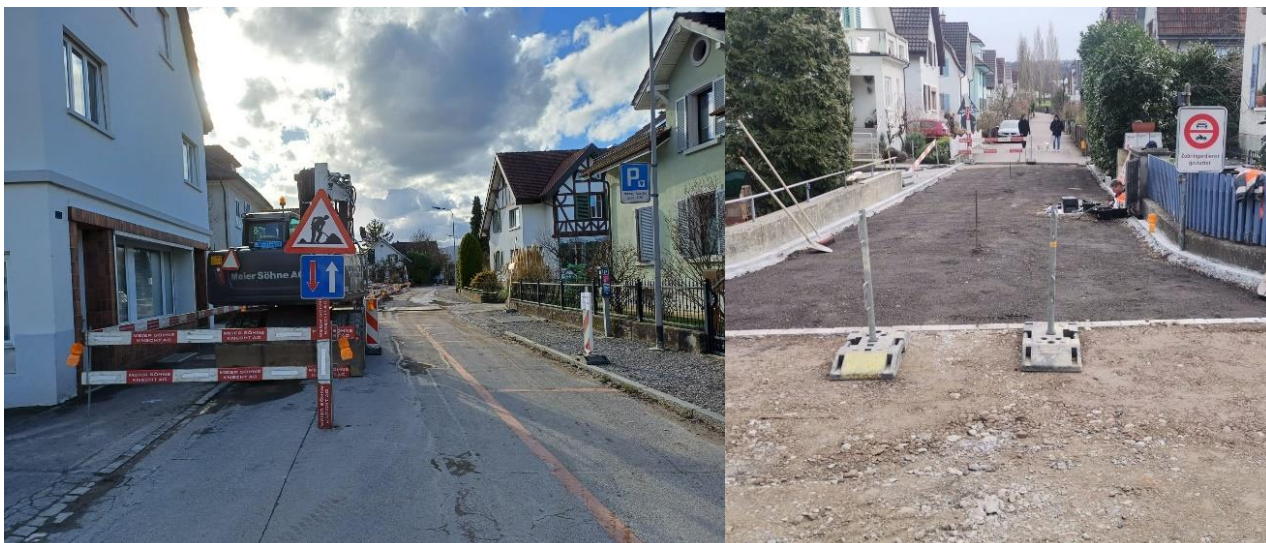
Bauarbeiten auf der Klosterzelgstrasse
