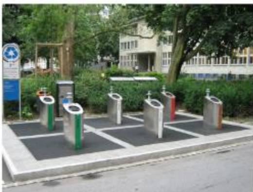
Beispiel einer Sammelstelle mit Unterflurcontainer
