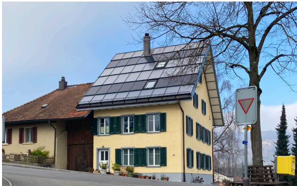
Beispiel einer Vollflächig angebrachten Indachanlage in Windisch.
