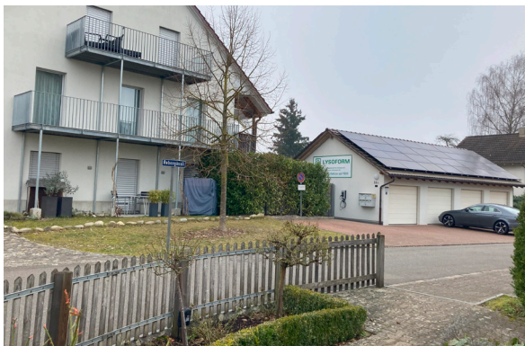
Vollflächige Aufdachanlage auf Nebenbau. Kernzone Windisch
