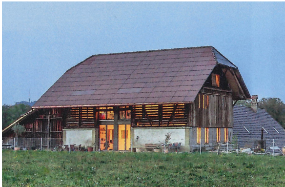
Solaranlagen: Bauernhaus in Wabern
