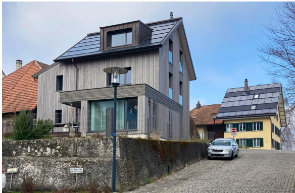
Sorgfältige Indachanlage auf einem Neubau. Kernzone Windisch
