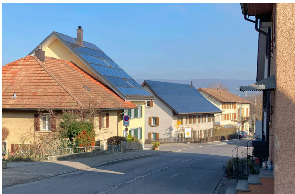
Gut einsehbare Dachflächen im Dorfkern Windisch: Vollflächig angebrachten Indachanlagen
