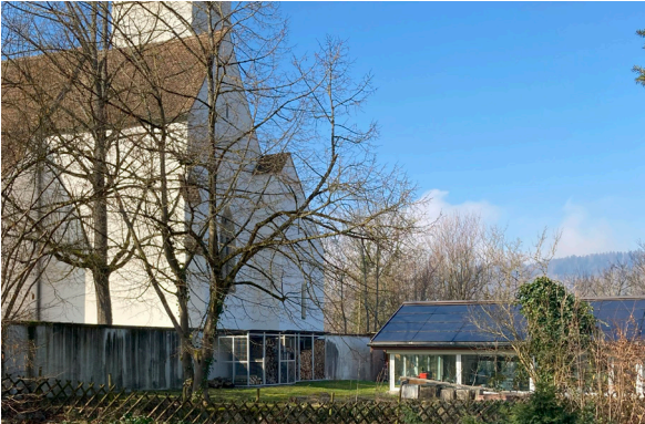
Indachanlage auf Nebenbau in sensiblem Umfeld. Kernzone Windisch
