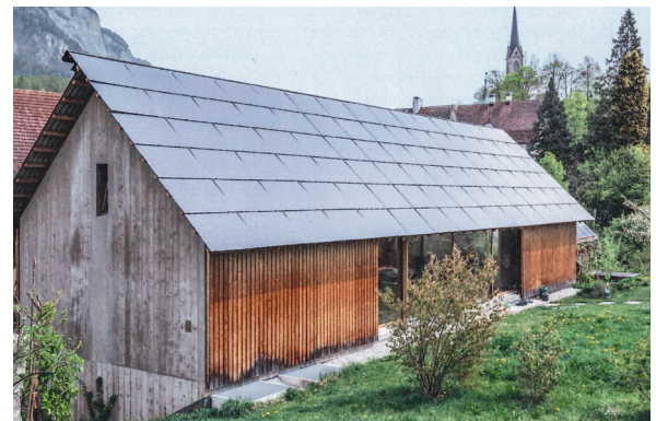
Geschuppte Solaranlagen: Neubau in Tamins
