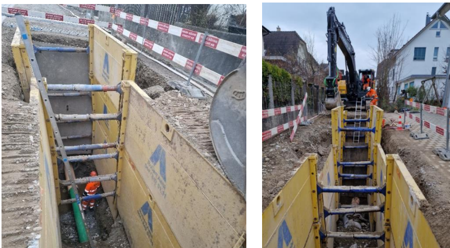
Kanalisationsbau im Blumenweg in 6 m Tiefe
