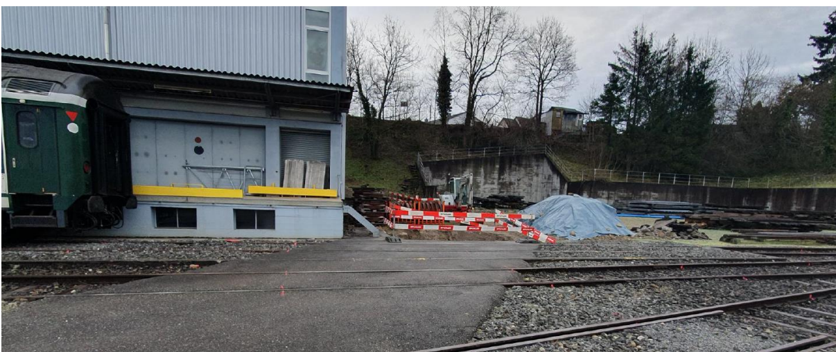
Werkleitungsbau Tulpen- und Pappelweg
