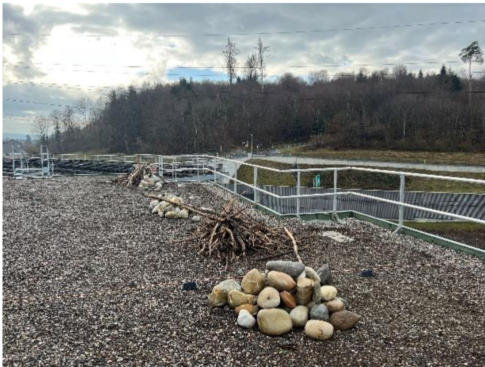
Flachdachsanieierung mit PV-Anlage und ökologischem Ausgleich.
