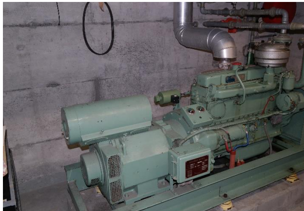
Bestehendes Notstromaggregat
