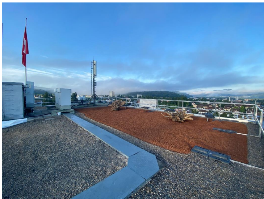
Im Spätsommer wurde das undichte Gemeindehausdach erneuert und gleichzeitig die notwendigen Antennenarbeiten ausgeführt.
