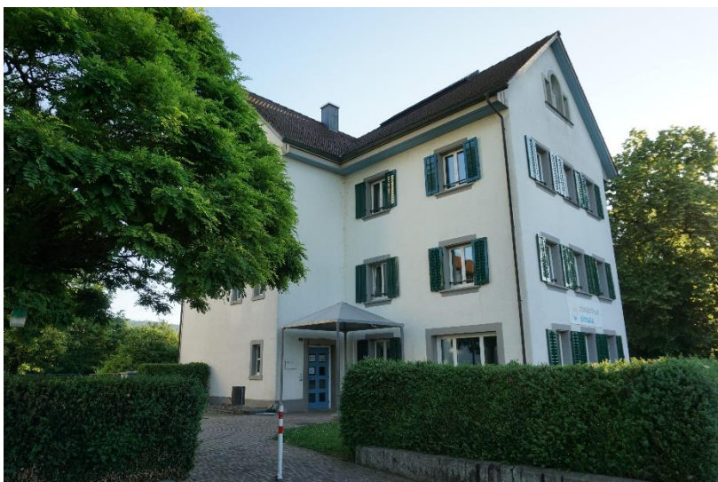
Das kleine Schulhaus erstrahlt in neuem Glanz.
