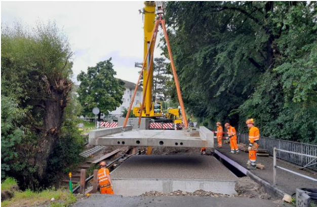
Kraneinsatz Sanierung Süssbachdurchlass
