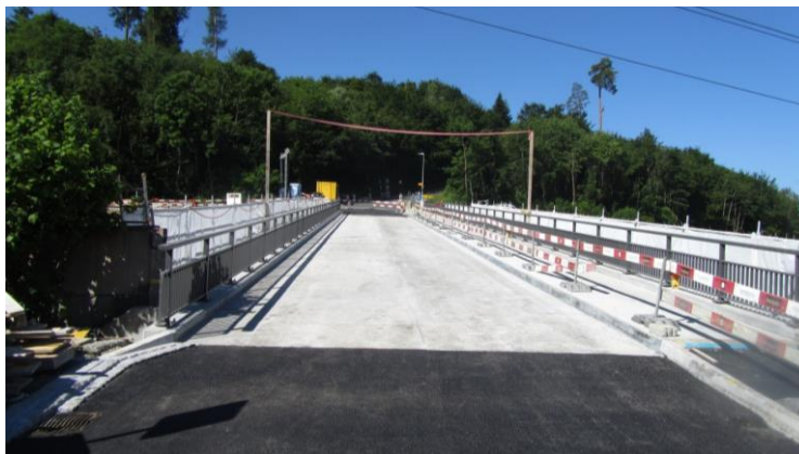
Neuer Belag Habsburgbrücke
