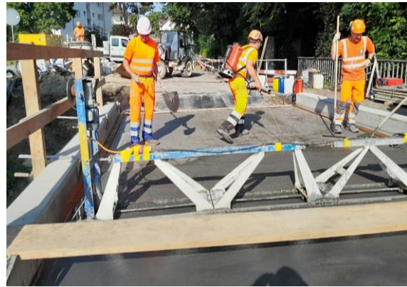
Belagseinbau Süssbachdurchlass
