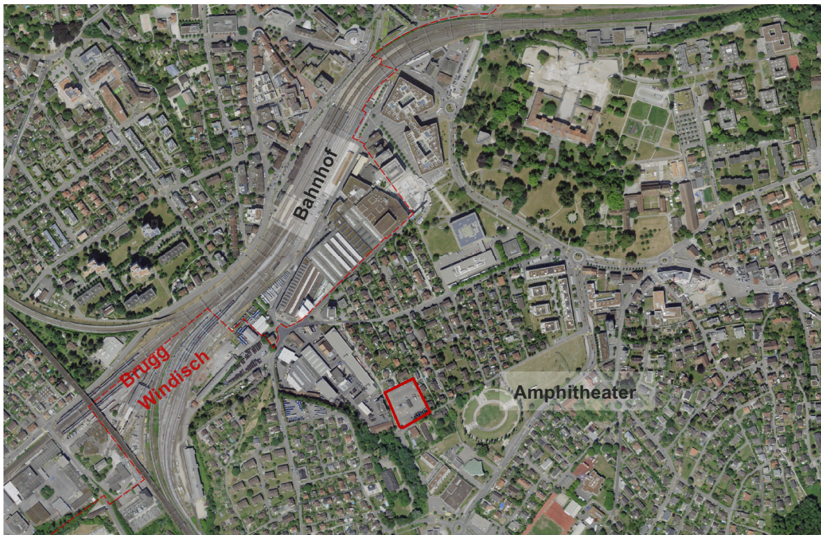
Abb. 3: Luftbild Areal «Bachmatt» im Kontext (Quelle Luftbild: geoadmin.ch)
