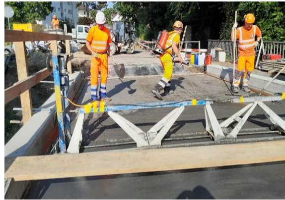
Belagseinbau Süssbachdurchlass
