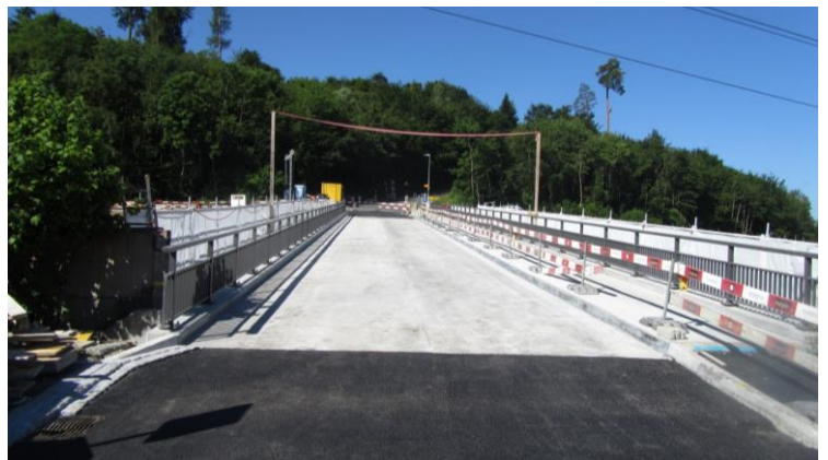
Neuer Belag Habsburgbrücke
