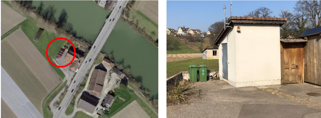
Abbildung 6: PW Fahrgut – Standortluftbild und Foto vor Bauwerk
