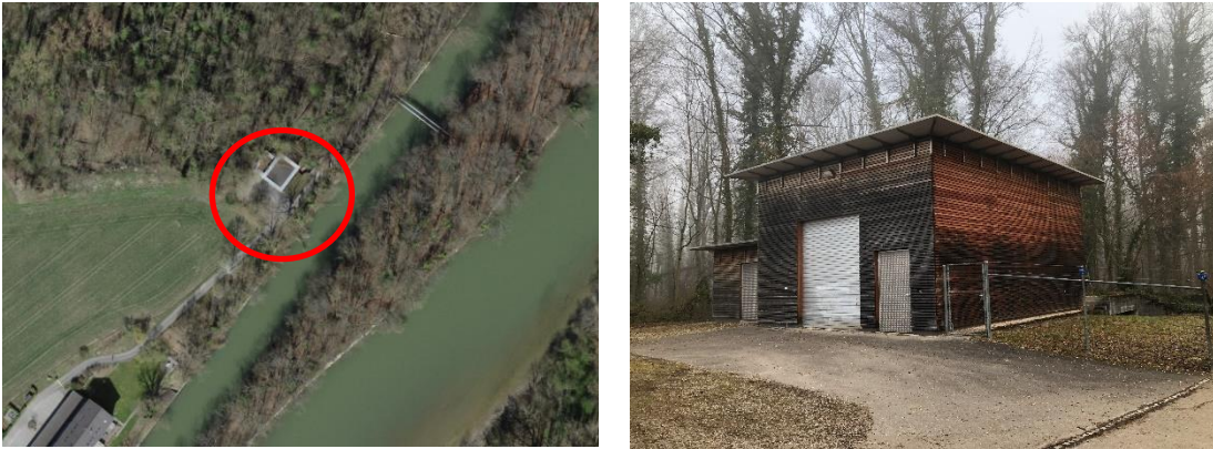
Abbildung 1: Standort und Ansicht FB / PW Schachen
