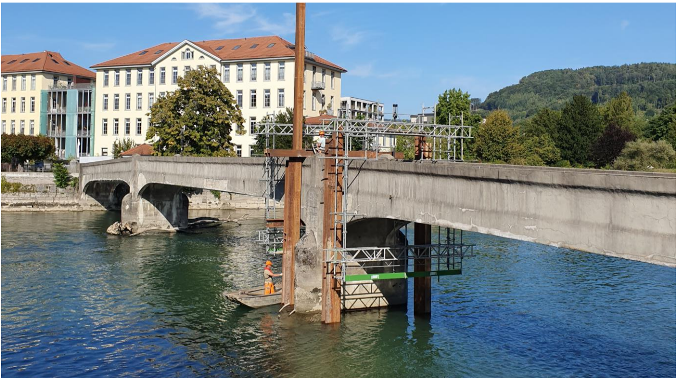
Abbildung 1: Montage der Stahlkonstruktion am 18.09.2019
