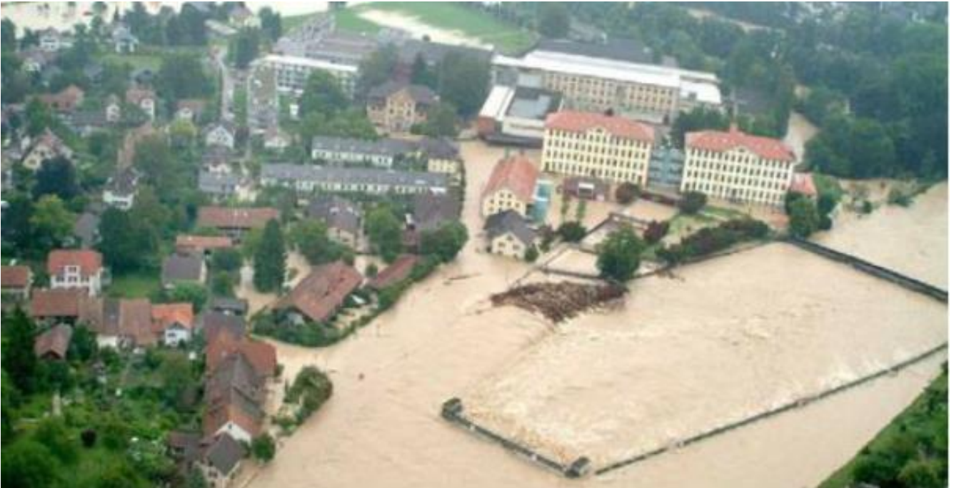
Abbildung 5: Reuss Windisch während des Hochwassers August 2005
