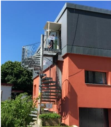
Wiedereröffnung 11.5. mit Einbahnbetrieb / Eingang der Bibliothek über die Feuertreppe
