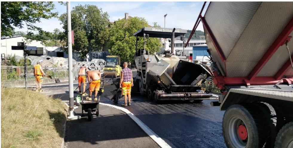
Abbildung 3: Foto Belageinbau Reutenenstrasse
