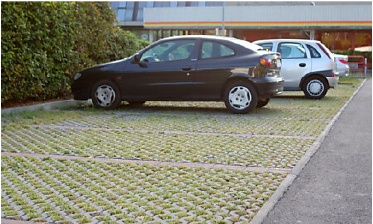
Entsiegelung mit Rasengittersteinen
