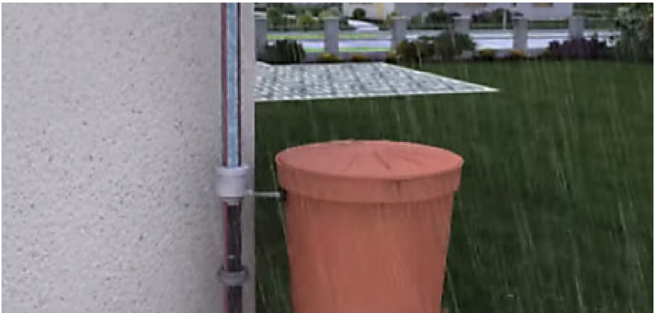
Beispielbild Regentonne gespeisen vom Regenwasser des Daches
